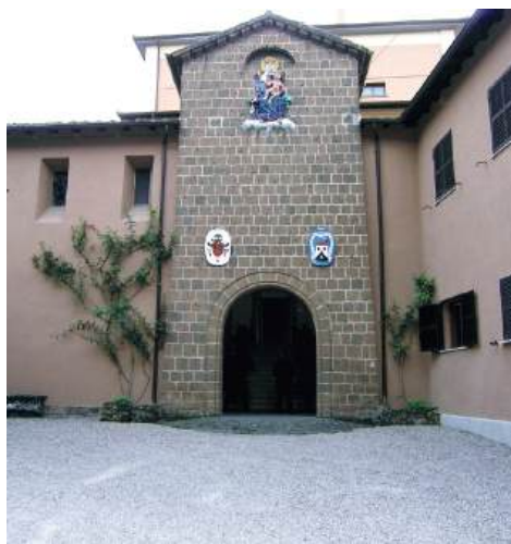
L'ingresso dell'attuale Monastero del Monte Carmelo.
